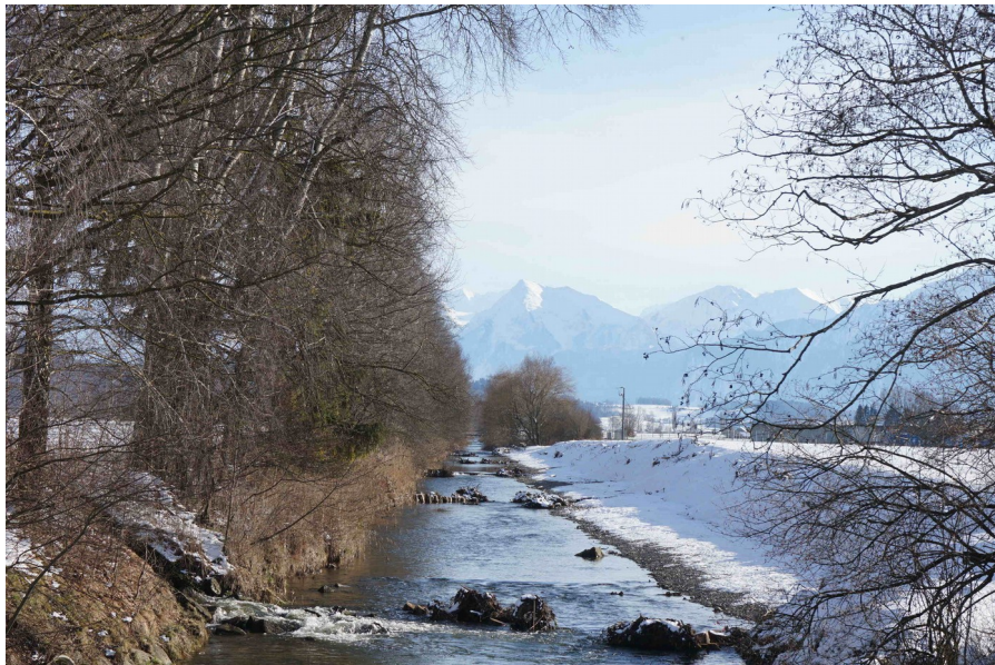
Fertiggebaute Teilstrecke bei der Müschemündung. Es fehlt noch die Bepflanzung
